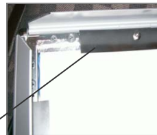
金具を取り外しLEDを交換
