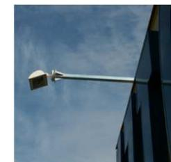
設置環境により連結可能なユニット型LED投光器！ 水銀灯の約1/3の消費電力
